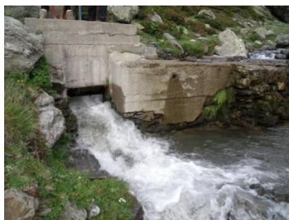
Imatge de l'assut en el torrent de Finestrelles a la cota 2027 m que es condicionarà per a la regulació i control mitjançant comporta de buidat de l'arqueta de captació.
