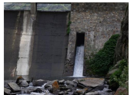
Imatge de la regulació del cabal ecològic del riu de Núria mitjançant el control de la comporta de fons de l'embassament
