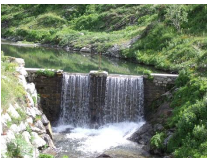
Imatge de l'enderroc parcial de l'assut del torrent d'Eina i construcció d'una escala de peixos
